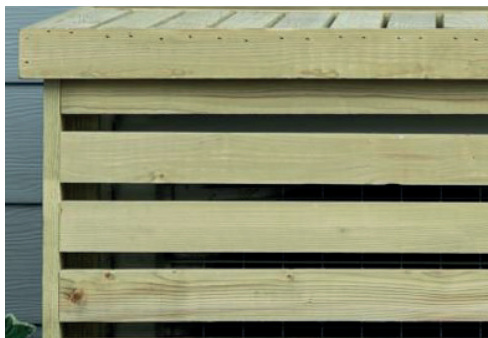
Mehr Raum zwischen den Lamellen führt zu einem besseren Luftstrom (ein/aus).
