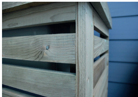
Ausführung mit geraden Lamellen (statt gewinkelten) Macht den Schrank kompakter. Sieht fester aus.
